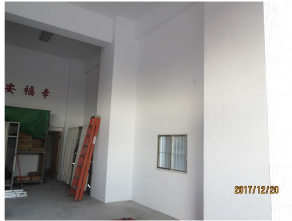
消防廳舍耐震補強(車庫)
