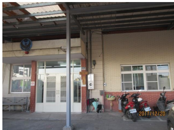
消防廳舍耐震補強(正立面)
