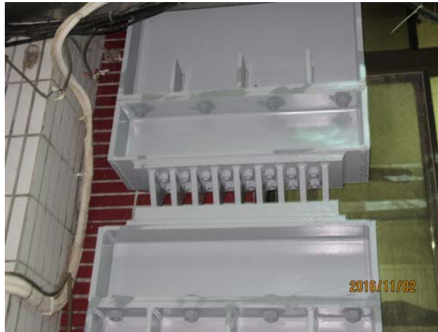
圖一：元長分駐所後側制震壁補強
