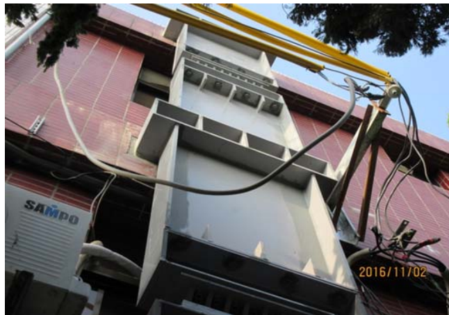
圖二：元長戶政所側面制震壁補強
