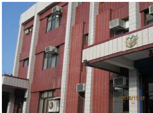
圖三：元長消防隊、元長分駐所正面補強
