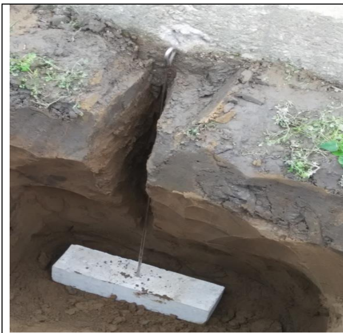
圖 5、每一斜柱以堅固材質（如水泥塊或鋼塊等）作為地錨，建議應深埋至少 1 公尺並夯實。
