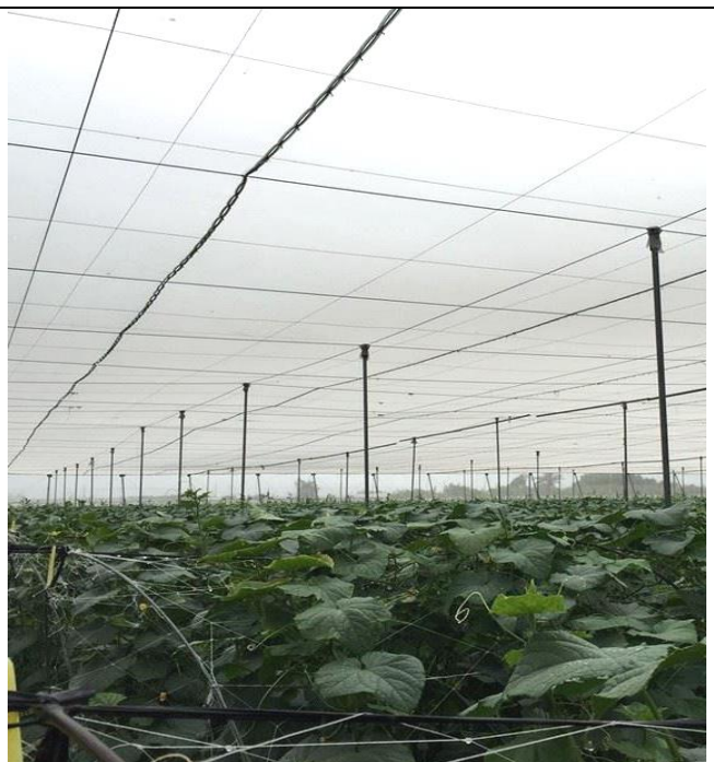
圖 4、網室內設置 1.5 英吋(含或以上)之立柱，間距約 10 公尺。
