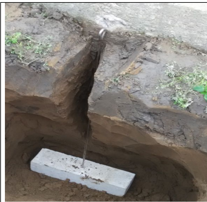
圖 5、每一斜柱以堅固材質（如水泥塊或鋼塊等）作為地錨，建議應深埋至少 1 公尺並夯實。
