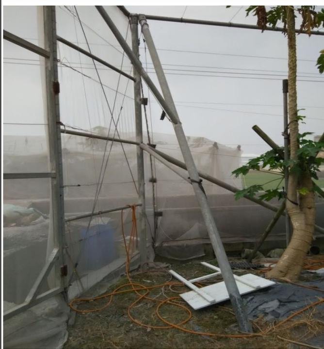
圖 1、網室 4 個角落角柱用 3 英吋(含)以上鍍鋅管，並在周邊以 3 英吋(含)以上鍍鋅管設置斜柱。
