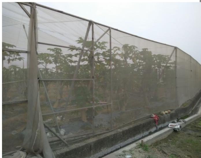
圖 7、塑膠防蟲網用固定壓條或不鏽鋼線等資材固定於網室結構上，以內外兩側塑鋼線或鋼索材質牽引，避免強風吹動受損。
