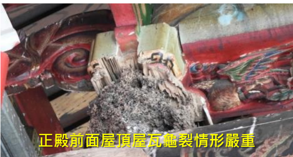
正殿前面屋頂屋瓦龜裂情形嚴重
