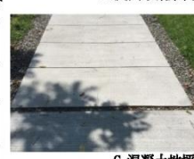
C. 混凝土地坪
