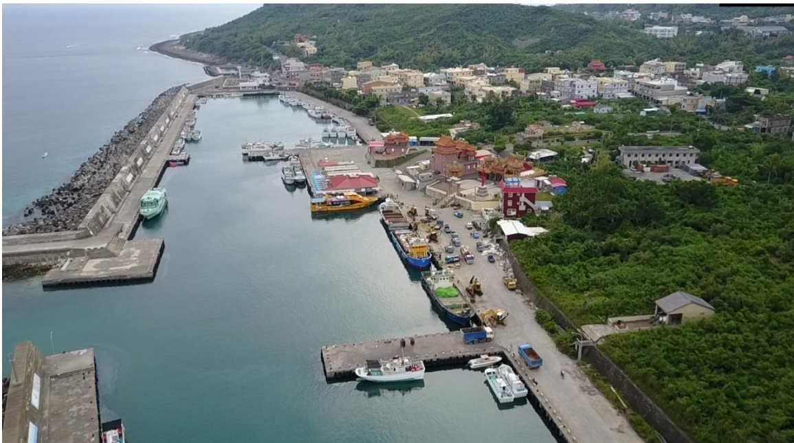
照片四 琉球新漁港客貨運船舶使用現況
