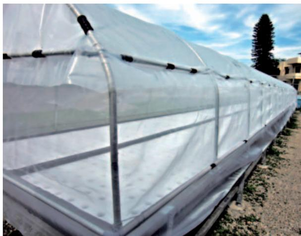
圖 3 養殖水耕系統中之水耕床
