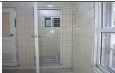
廁所未加裝扶手
