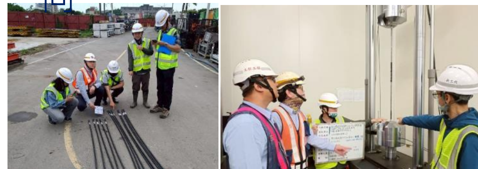
淡江大橋主橋塔斜拉鋼索第8批取樣、會驗
