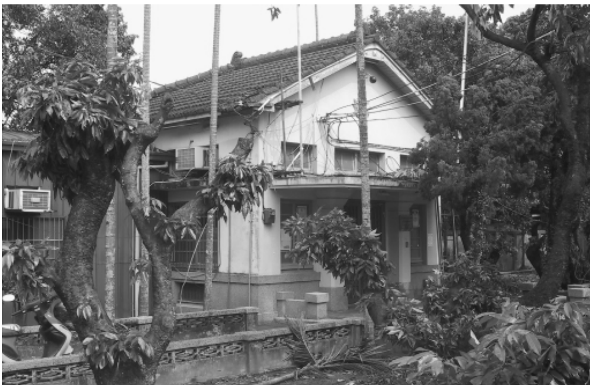
溝埧派出所正面（黃衍明攝於西元2005年8月）
