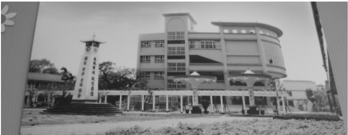
相片8-25 新建教學、行政大樓（鎮西國小提供）
