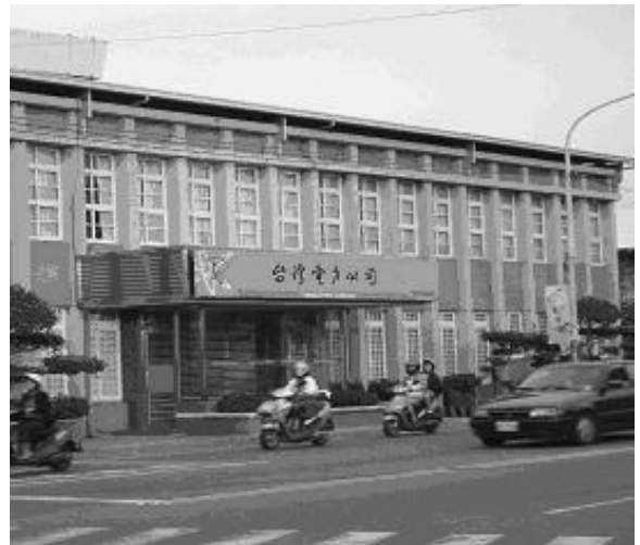
台灣電力公司雲林區營業處一隅
