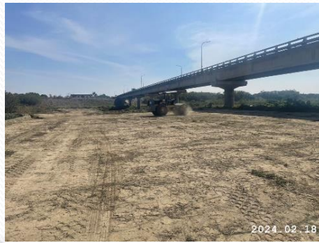
P6基樁載重試驗場地
