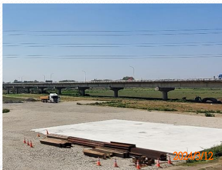
基樁鋼筋籠加工場
